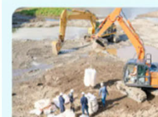
建設現場の 遠隔臨場
